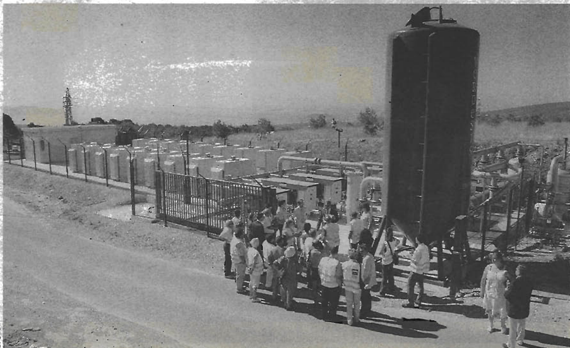
Située à l'entrée de la décharge, la centrale électrique est opérationnelle depuis le 1er juin.
